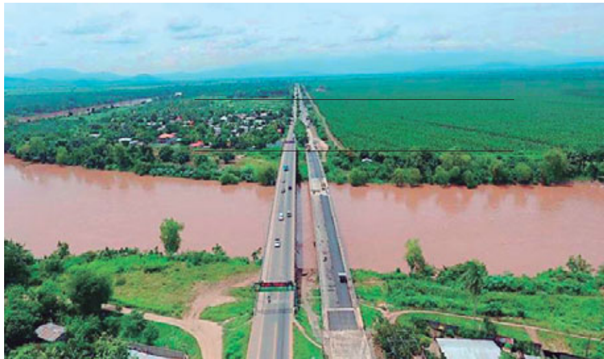
Así luce el puente ya reparado y listo para ser habilitado.
