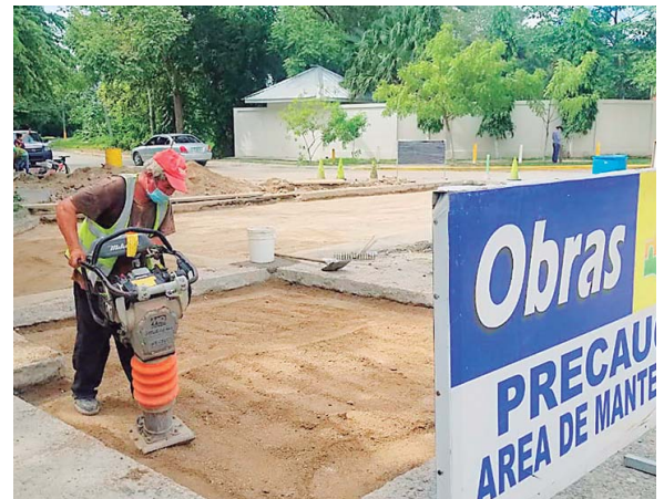
Los trabajos de mejoramiento con concreto hidráulico en la calle entre residencial El Pedregal y el acceso a PriceSmart ya concluyeron.
