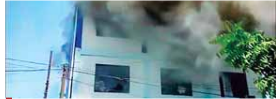
El incendio se suscitó en una tienda que distribuye equipo médico y tanques de oxígeno.
