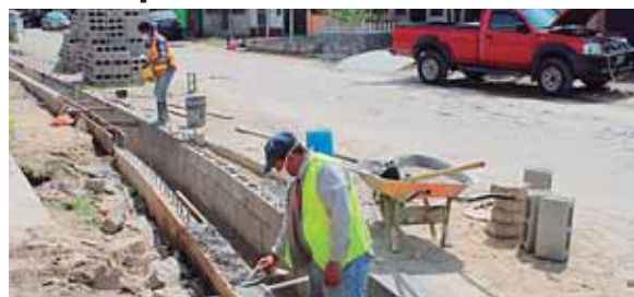
Los equipos continúan con los trabajos de fundición del canal, del cual llevan 100 metros lineales de construcción.
