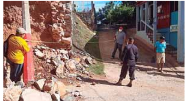
La construcción del área de visita permitirá a las mujeres atender a sus familiares de una manera más cómoda.
