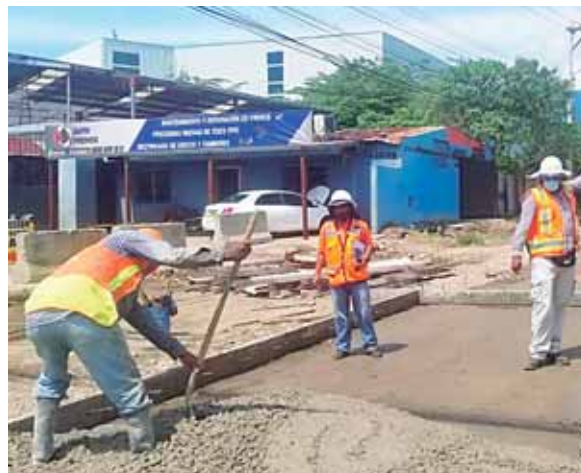
La ampliación a cuatro carriles de la 2 calle permitirá a los conductores un acceso más rápido y fácil al paso a desnivel.
