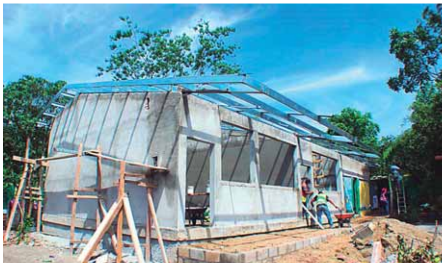
Las mejoras incluyen el techo que estaba muy deteriorado, cambio del sistema eléctrico, piso entre otros.
