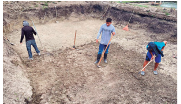
Para continuar alistando el terreno tuvieron que contratar a varios empleados quienes realizaron un arduo trabajo en la excavación.
