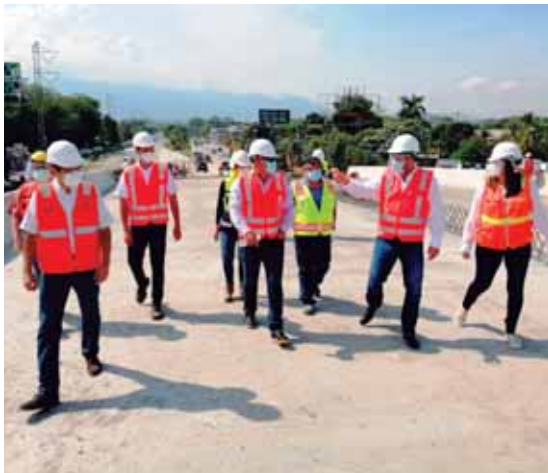
El alcalde Armando Calidonio junto a representantes del proyecto Siglo 21 en el recorrido de la obra paso a desnivel.
