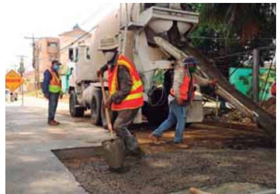
La obra cada vez va avanzando. Con su culminación, el tráfico vehicular será más fluido.
