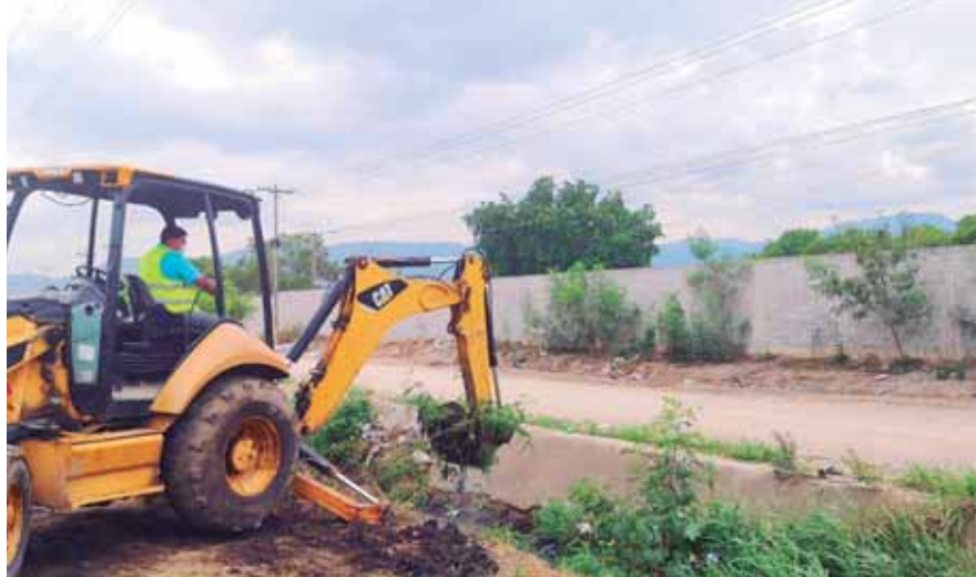
Ante el comienzo del temporal lluvioso, la comuna ha decidido realizar la limpieza de los tragantes y cunetas a fin de evitar inundaciones.
