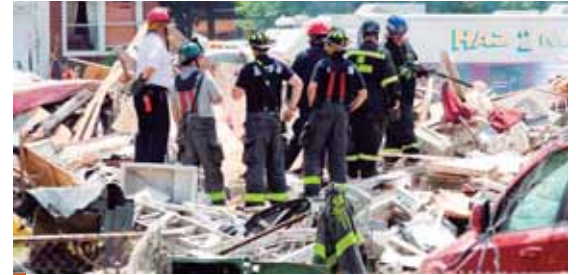
Las causas de la explosión de gas están bajo investigación, informaron autoridades.
