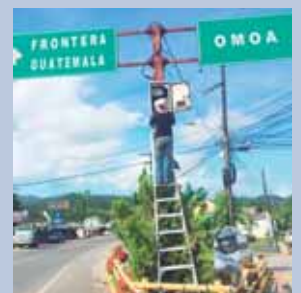
La instalación, se realizó en una de las principales calles del sector, lo que permitirá un mejor orden y flujo vehicular.
