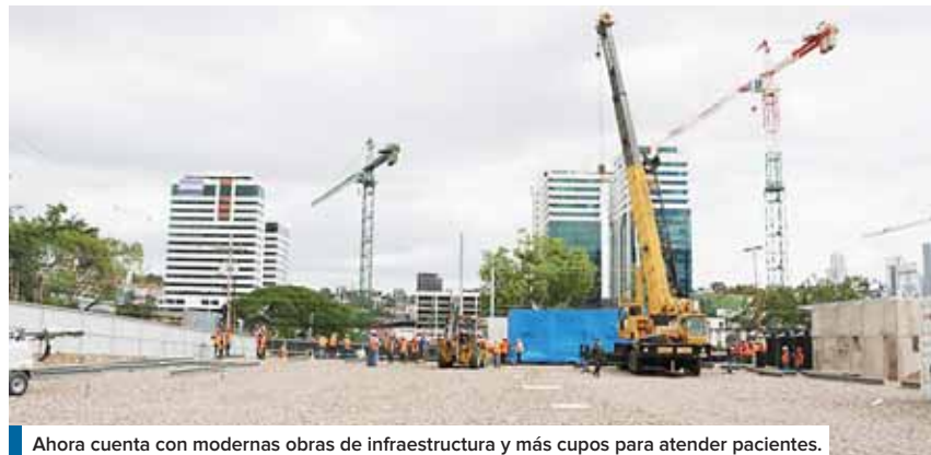
Ahora cuenta con modernas obras de infraestructura y más cupos para atender pacientes.
