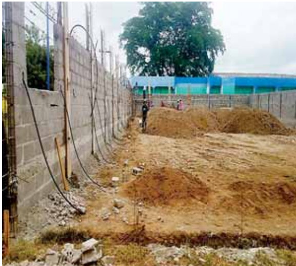
El proyecto está en la fase de la culminación de las paredes y esta semana trabajarán en la base del piso.
