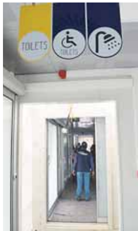
Ayer se continuó con el proceso de instalación de la electricidad y de servicios de agua, en San Pedro Sula.
