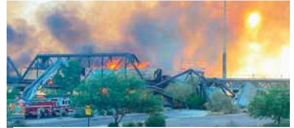
El fuego se propagó rápidamente casi hasta la mitad del puente.
