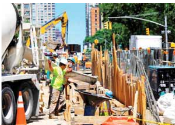
Entre 200,000 y 400,000 personas volvieron ayer a sus puestos de trabajo, ayer se reactivaron varias obras.
