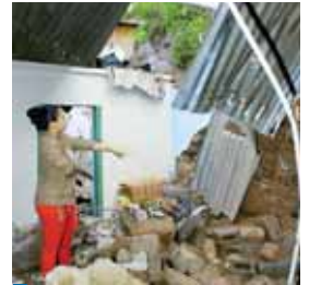
En la capital, alrededor del 80 por ciento de las viviendas se encuentran construidas en sectores que representan algún riesgo.
