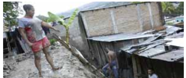
En la capital muchas personas quedan sumamente expuestas ante la vulnerabilidad provocada por las lluvias.
