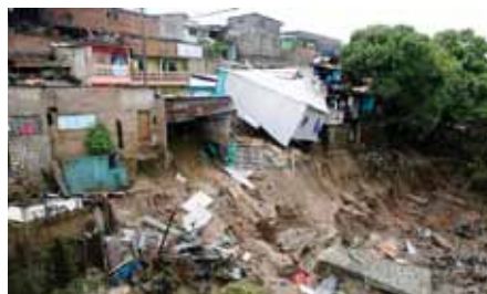
Se han registrado cortes de energía eléctrica, que afecta el suministro de agua potable por daños en la red de distribución y derrumbes en carreteras.
