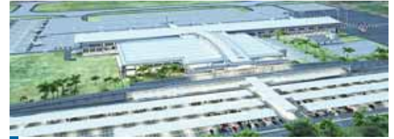
Antes de la suspensión de labores, el avance en la construcción del Aeropuerto Internacional de Palmerola ya estaba al 65%.
