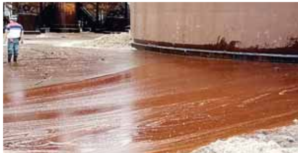
Los elementos del Cuerpo de Bomberos colaboraron en el control de la fuga en el tanque de almacenamiento.
