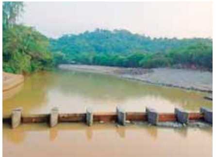
Así luce la presa de Danto. La profundidad de su cauce es de tres metros y medio.
