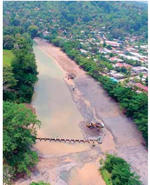
Este es el embalse que se ha construido para guardar 16 millones de galones de agua y distribuirlos en la ciudad
