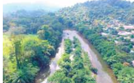
Así lucía la presa de Danto, de allí solo se sacaban unos cuantos miles de litros de agua los cuales no eran suficientes para abastecer la ciudad.
