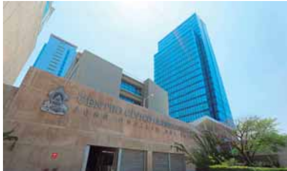
Parte del inmueble podría estar habilitada en dos o tres semanas para fines sanitarios. Se podrían albergar hasta 3,000 personas.
