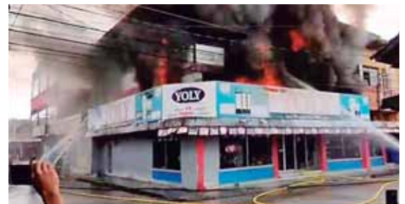
Los apaga-fuegos expresaron que el inmueble se quemó casi en su totalidad.
