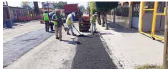
El proceso de reparación comprende la aplicación de una mezcla a base de asfalto en caliente para luego dar una cobertura de grava.
