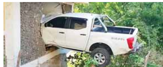
Solo se reportó daños materiales, según la información que se manejó ayer.
