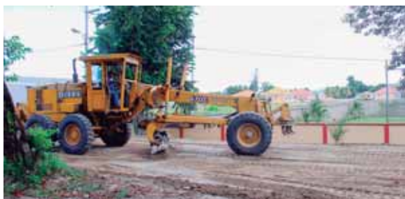
Los trabajos de mantenimiento de la red vial no pavimentada se efectúan con recursos municipales.
