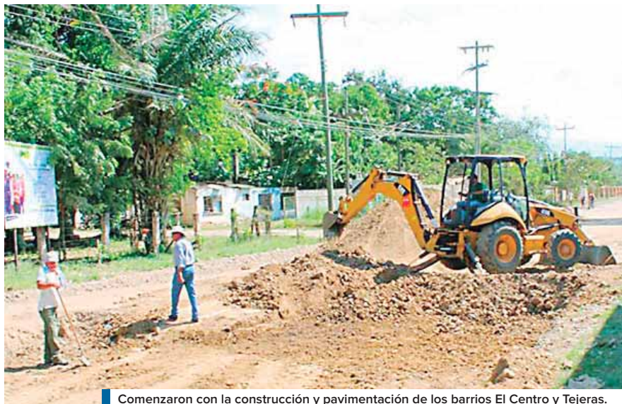
Comenzaron con la construcción y pavimentación de los barrios El Centro y Tejeras.
