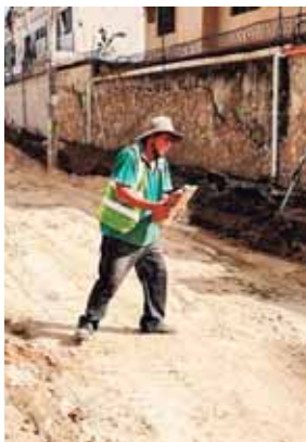
La ampliación consiste en la construcción de una trocha adicional.
