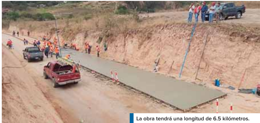
La obra tendrá una longitud de 6.5 kilómetros.
