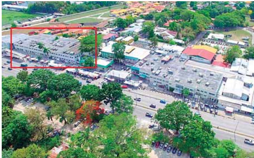
El edificio fue incautado en el año 2009 por el Ministerio Público y pertenece al Instituto Hondureño de Seguridad Social. Según los trabajadores, las instalaciones están deterioradas por el abandono.
