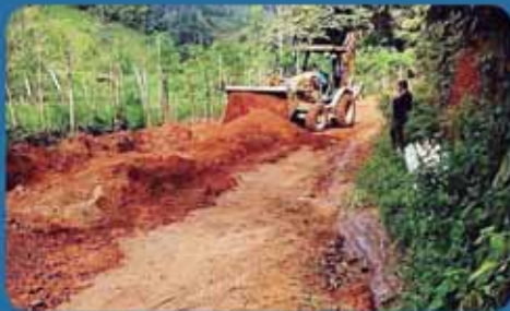
Como parte de los proyectos, se realizan reparaciones periódicas de carreteras de terracería, como esta de aldea Cerro Negro, en el sector Merendón.
