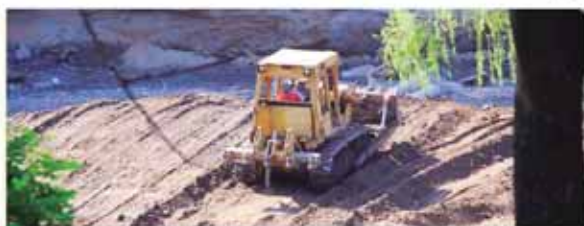
La canalización permitirá que las corrientes de agua fluyan sin ningún impedimento evitando así las posibles inundaciones.
