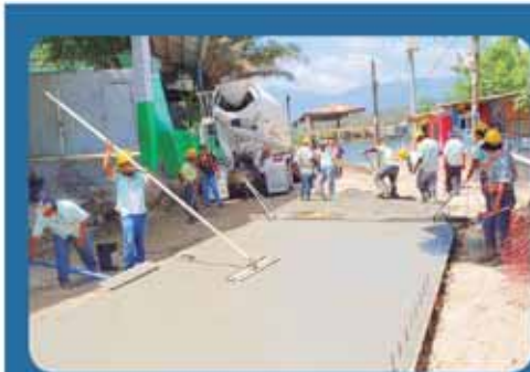
Pavimentación de la colonia López Arellano.
