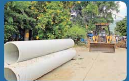
Cambio de tuberías para proyecto de pavimentación en el centro de la ciudad.
