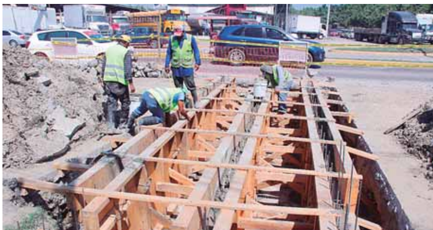
El proyecto también incluye la instalación de tubería de 30 pulgadas.
