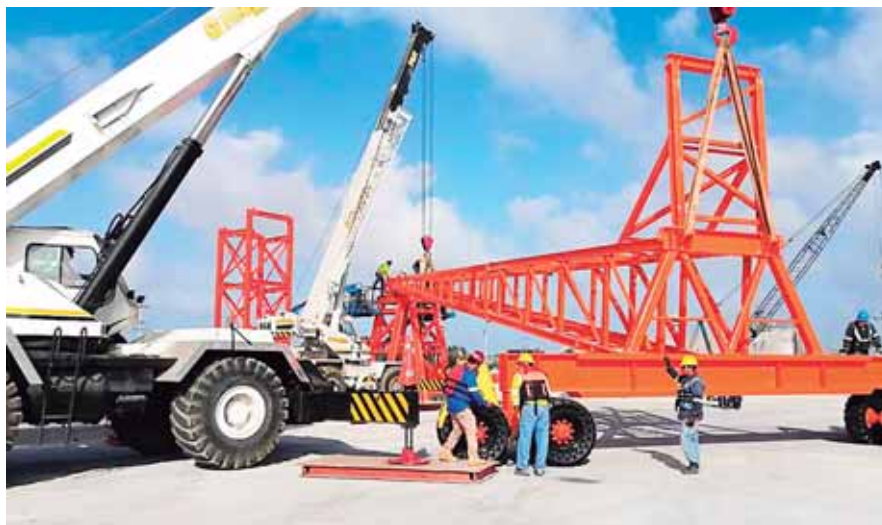
Este nuevo muelle que ya está terminado es un proyecto ejecutado mediante una inversión Alianza Pública Privada, APP, de 18.5 millones de dólares, construido en un promedio de cinco meses.
