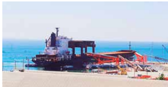
Este muelle granelero, como nuevo operador logístico, prestará los servicios carga, descarga, transferencia de carga, entre otros.
