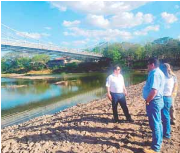
Unos 60 diques están en proceso de construcción para enfrentar la sequía en comunidades ubicadas en el Corredor Seco.
