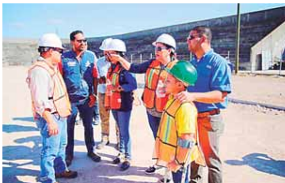
La esposa del mandatario aprovechó su visita a La Paz para supervisar las mejoras que se realizan en el estadio Roberto Suazo Córdova.
