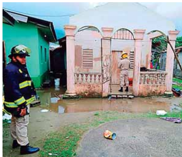
El temporal causó un tornado en Corozal, La Ceiba, el cual dejó daños materiales en viviendas.
