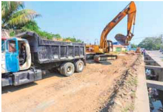
El proyecto lleva muy buen avance, la obra también incluye la construcción de aceras y señalización vial.
