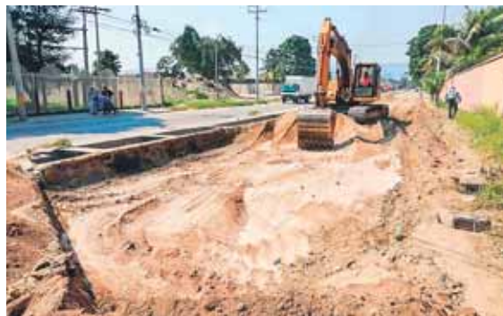
Los colaboradores municipales avanzan con el retiro de capa vegetal y excavación, remodelación de la sub base y relleno.
