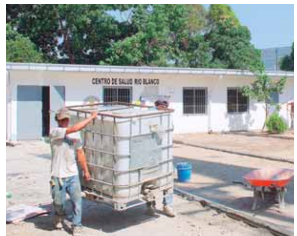
Se está ampliando las áreas de vacuna, colectoría, enfermería, farmacia y sala de espera.
