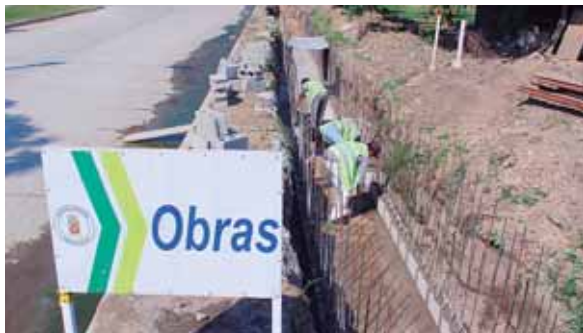
Una parte de los canales quedarán abiertos, mientras que otros tramos serán embaulados.
