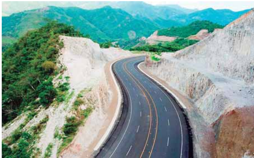
La inversión será en los rubros de infraestructura vial, productiva y de servicios sociales.
