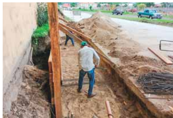
La obra tiene una longitud de 2.5 kilómetros y beneficiará a más de 50 mil vecinos y 20 colonias.
