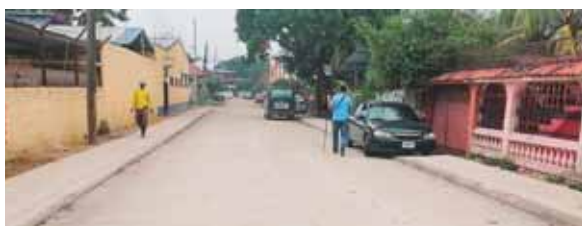
La obra contempla la pavimentación de 210 metros lineales con losas de concreto, bordillos y aceras.
