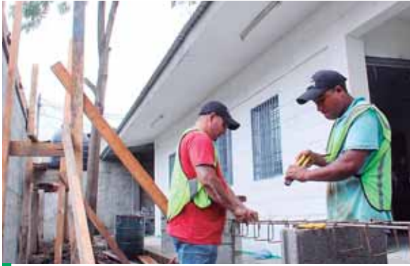
Las modificaciones se realizan en la estructura interna del centro.
