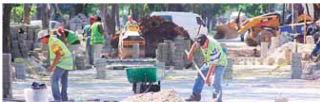
El adoquín que se está colocando es de excelente calidad, tiene muy buena resistencia y filtración de agua.
