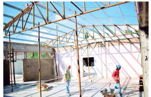
El asilo está ubicado en barrio Medina y muy pronto gozarán de nuevas instalaciones en el mismo lugar.
