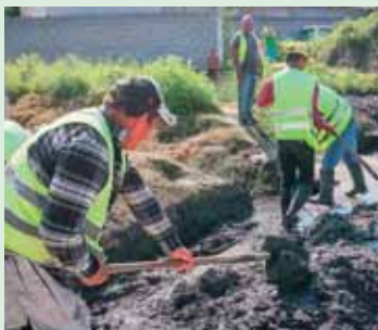
Los trabajos de mantenimiento del sistema pluvial se seguirán realizando.
