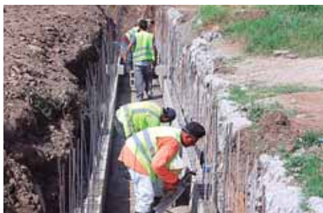
La obra ayudará a drenar más rápido las aguas lluvias, que permitirá el buen estado la calle que conduce a ese lugar.
