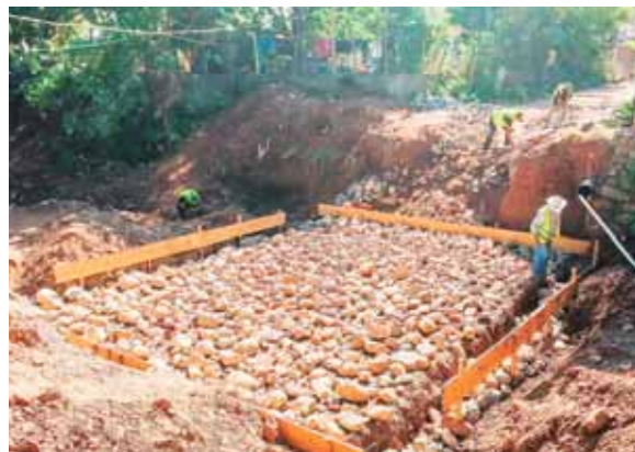
Esta es la tercera caja puente que la comuna sampedrana ejecuta en ese distrito.
