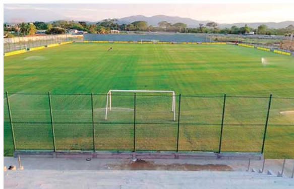
La construcción de una segunda gradería está por buen camino. Hermosa vista panorámica del estadio.
