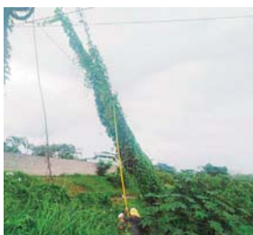
Constantemente realizan los mantenimientos.
