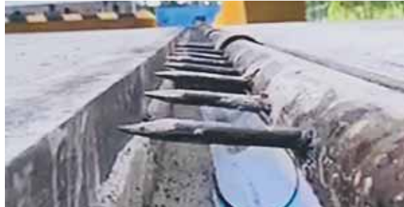
Las “lanzas” evitarán que los motoristas del transporte de carga pasen por el peaje sin pagar.
