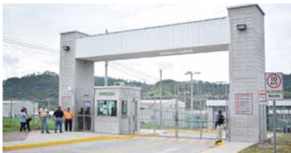
Fusina ha tomado el control de las cárceles de máxima seguridad; “El Pozo” en Ilama, Santa Bárbara y “La Tolva” en Morocelí, El Paraíso.
