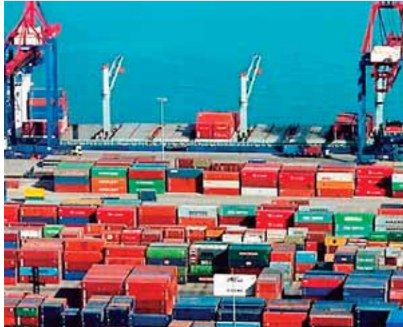
Puerto Cortés es el puerto más grande de Centroamérica en términos de tráfico, y uno de los mejores en equipamiento.
