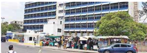
Estos son los primeros cinco quirófanos de los 20 que serán remodelados en el centro asistencial.
